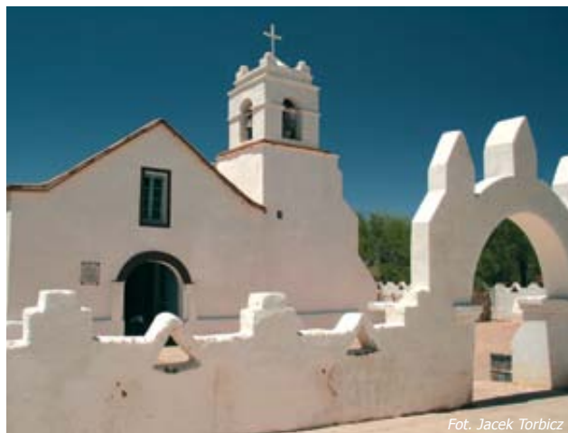
Kościółek św. Piotra w San Pedro de Atacama został zbudowany z adobe, tradycyjnego materiału Indian. Jest jednym z najstarszych w Chile.
